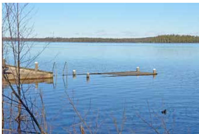
Lite översvämning på bryggan vid rampen på varvet.
